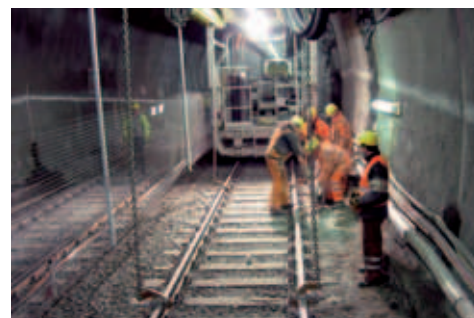
Trennen des Gleises und Anschlagen der Krananlage
