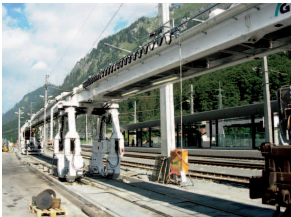
Einfahrt in den Arlbergtunnel
