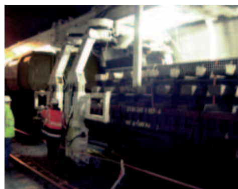
Stützwagen III ausgeschwenkt zum Einfahren der Flachwagen
