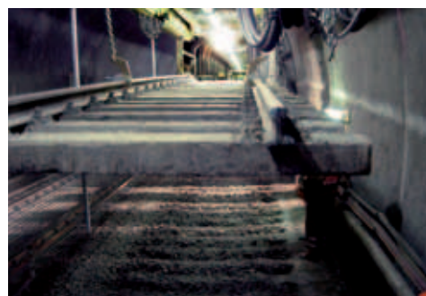
Anheben des Gleisrecks
